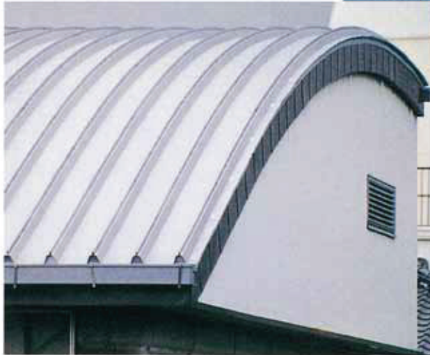
沼津漁卸売倉庫(静岡県)
